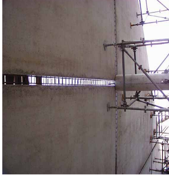
Figur 2 og 4. Samling af søjle-pladekonstruktionssystem ved Aalborg universitetets 8. Byggesnit. Samlingen er med CRC-jointcast. (3).
